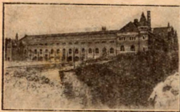
Københavns nye Centralbanegaard under Opførelse. Den toges i Brug 1911.
