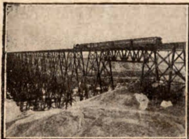
En vældig Jernbanebro i Kanada. Den hviler paa 53 Staaltaarne.
