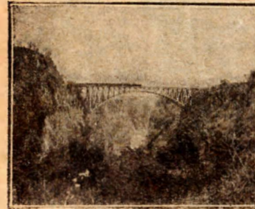
Jærnbanebroen over Zambesi.
